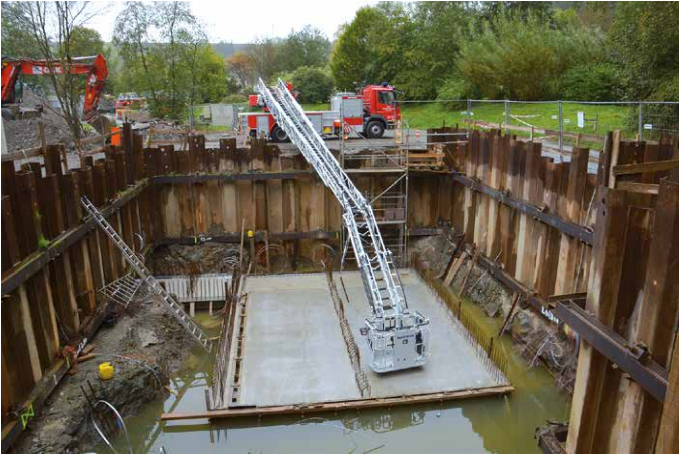
Rettung aus einer Baugrube
